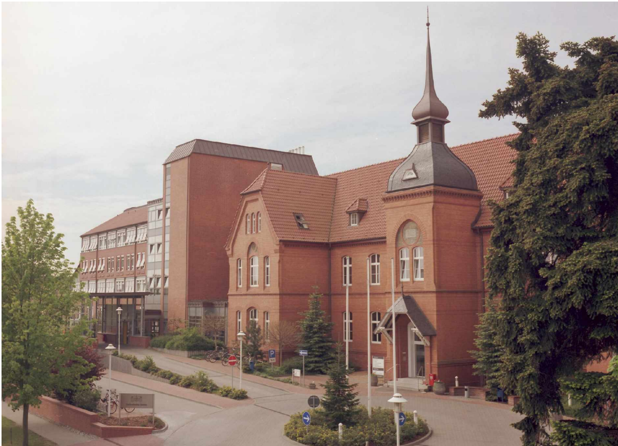
Ansicht des historischen Haupteingangsportales.
