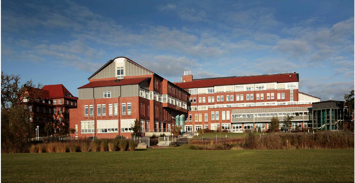
Rückansicht des Krankenhauses.
